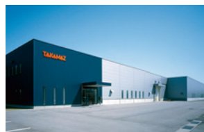
開発センター(IT関連製造装置)
