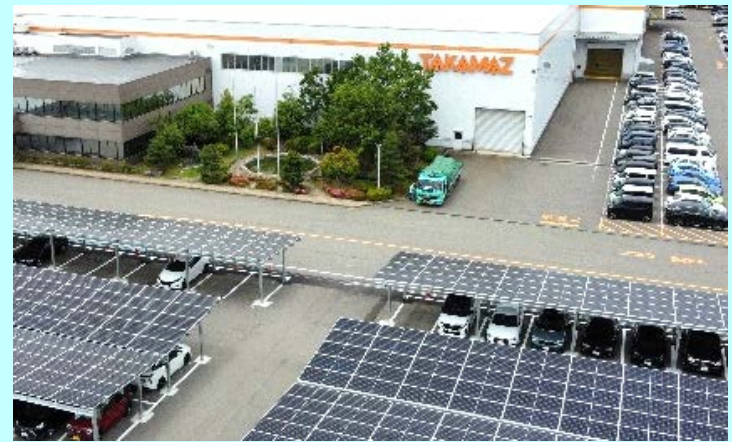
本社工場のカーポート型太陽光パネル
